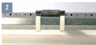
2 Schnellverbinder und Befestigungsringe auf die Welle legen
